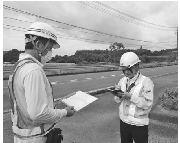
写真 - 3 国道工事の現場打合わせ
