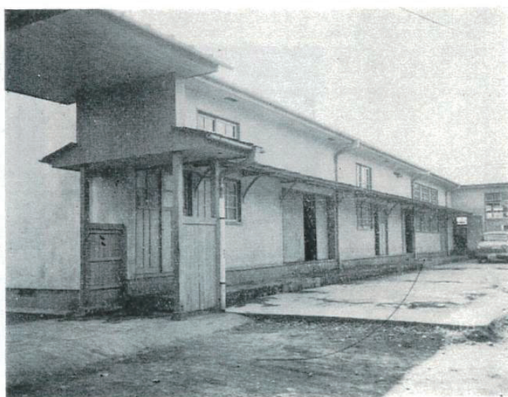
建築科実習場の外観
