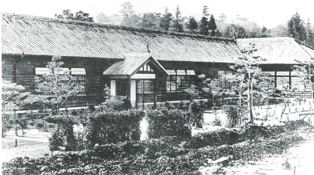
開校当時の校舎正面玄関（旧北与力町・現永国寺町・現高知女子大所在地）
