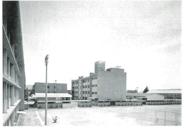
（1号館と2号館の間に完成した食堂）
