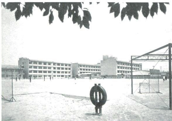
(運動場側より見た校舎)
