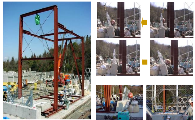
図 4 落石防護柵基礎の実物大実験(H13 年度)
