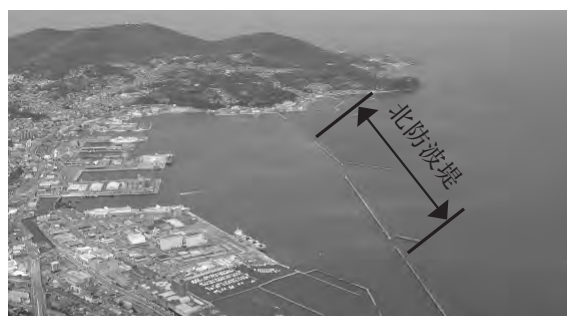
「現在の小樽港と北防波堤を南側より望む」
