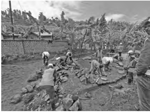
雨水を逃がすための溝を作る
