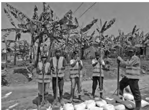
土のうを叩いて強度を上げ、上から土を被せて道を補強していく
