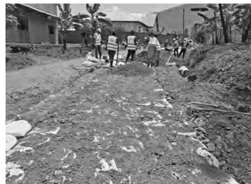
土のうを叩いて強度を上げ、上から土を被せて道を補強していく
