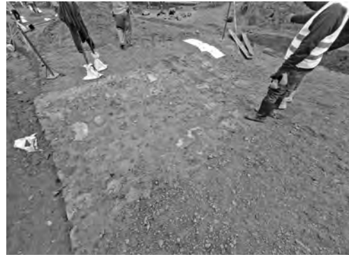
雨水を逃がすための溝を作る
