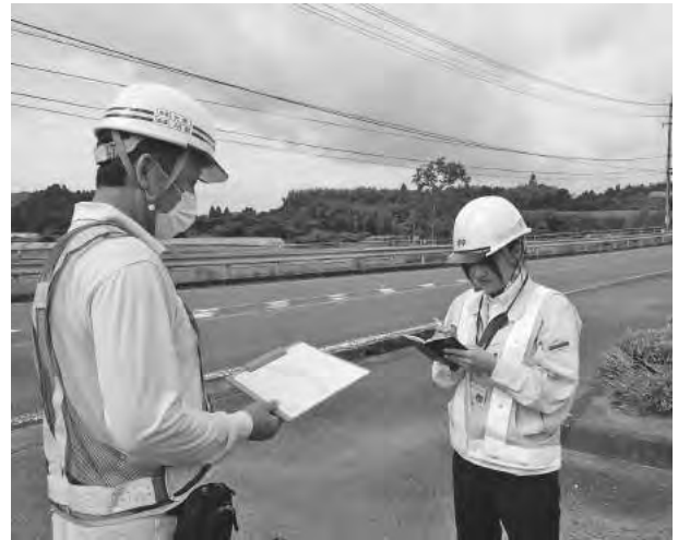
写真 - 3 国道工事の現場打合わせ
